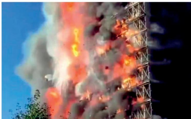
I pannelli combustibili del rivestimento esterno bruciano violentemente, si staccano dalla struttura metallica di sostegno e cadono in fiamme intorno all'edificio.
