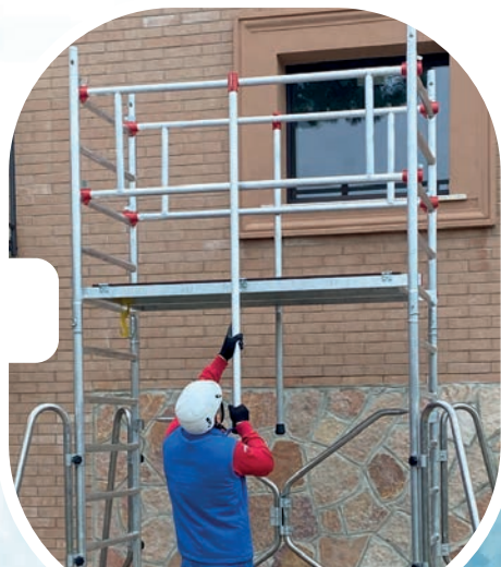
MONTAGGIO DEI PARAPETTI DAL BASSO
