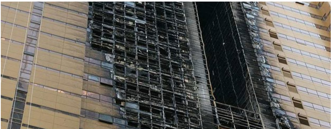
DIFFUSIONE DELL'INCENDIO ALL'INTERNO DI CAVITÀ VERTICALE INTERNA
