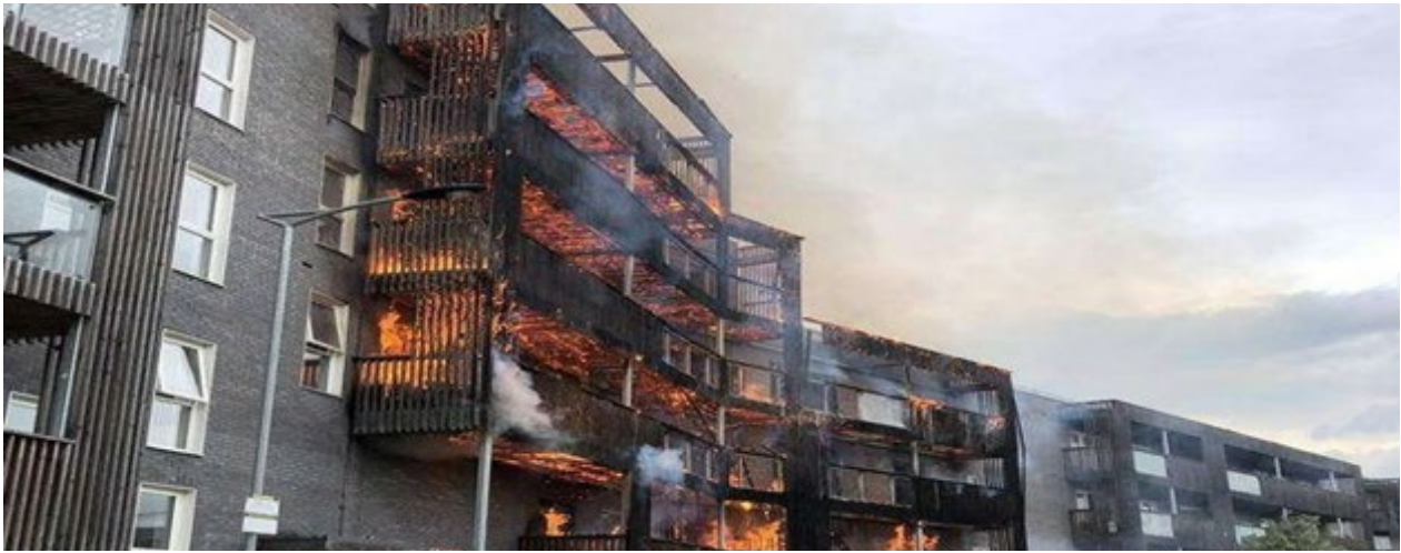
DIFFUSIONE DELL'INCENDIO TRAMITE BALCONI ESTERNI
