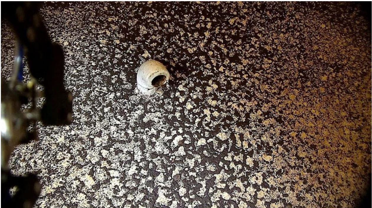
Foto 3: rilievo interno del recipiente con fotocamera HD del braccio robotizzato
