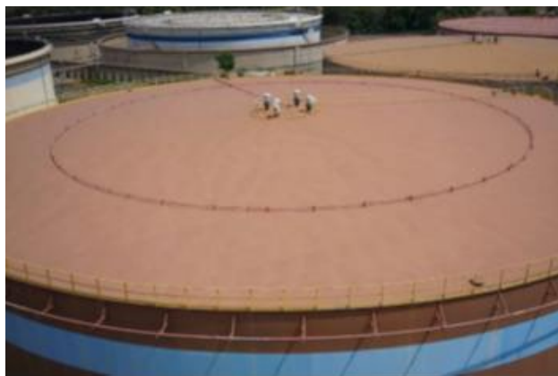
Figura 4 – foto del tetto del serbatoio
