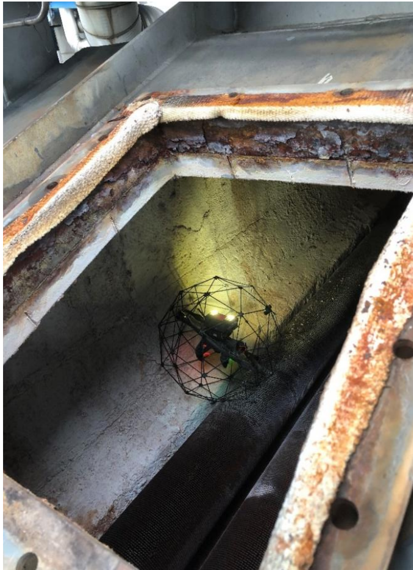
Foto 1: accesso con drone in spazio confinato
