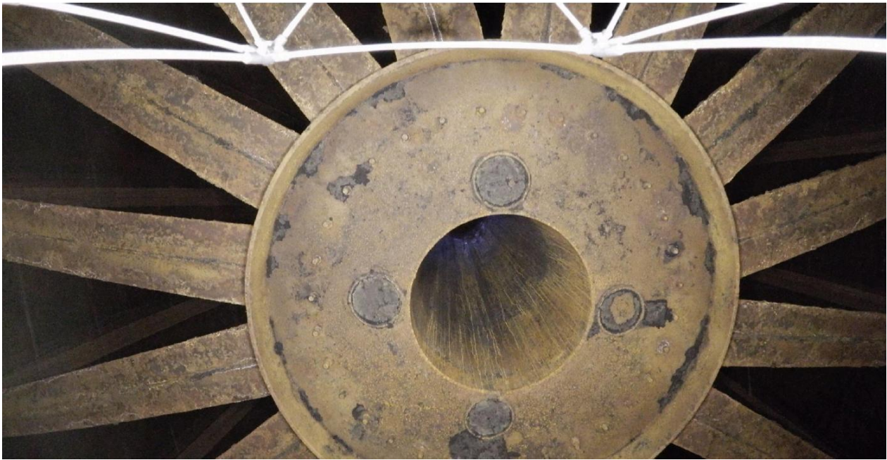
Foto 4: rilievo del monaco del tetto di un serbatoio con drone
