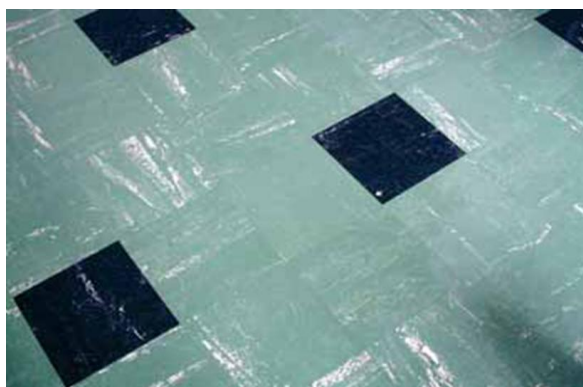
Figura 11 - pavimento in vinil-amianto
