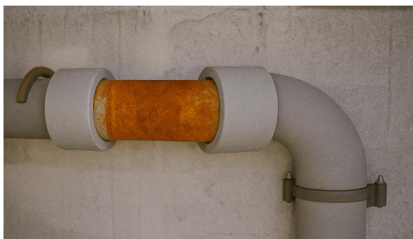
Figura 9 - condutture in cemento-amianto
