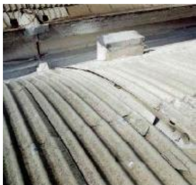
Figure 30 - tettoia in cemento amianto in discreto stato di conservazione (sx); cassoni per l'acqua in cemento amianto in buono stato di conservazione (dx) (fonte: Inail, Conoscere il rischio/polveri e fibre/amianto)
