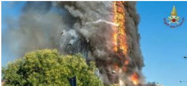
Torre del Moro Milano, 2023
