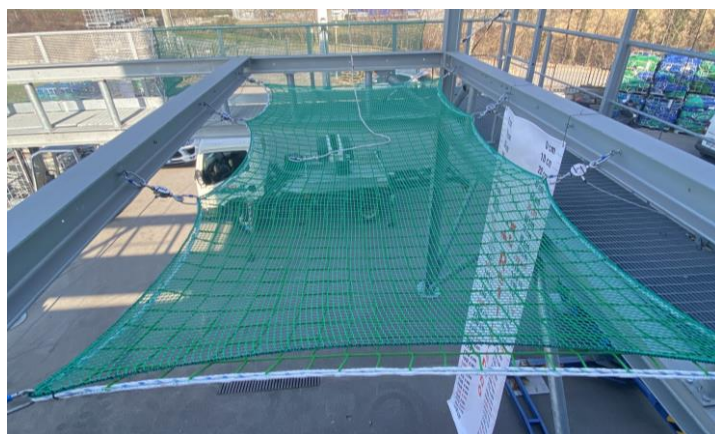
Figura 6.2.2.2-3 Esempio di rete in polipropilene doppio strato maglia 100x100 mm più maglia 20x20
