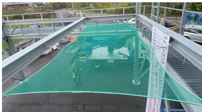
Figura 6.2.2.2-2 Esempio di rete in polipropilene con maglia 20x20
