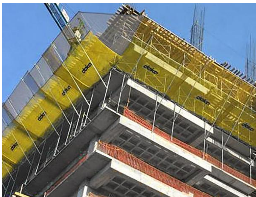
Figura 4.4-1 - Safety net fan (Doka)
