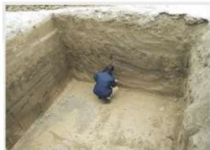
Figura 4 Fossa con possibile presenza di CO 2 , H 2 S, SO 2
