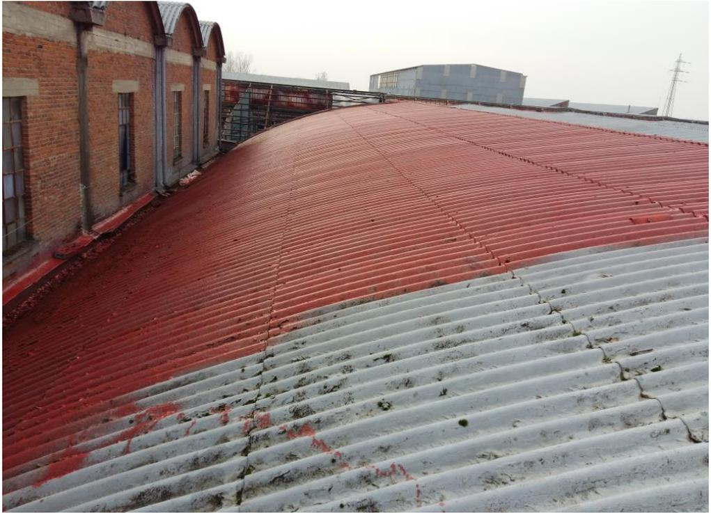
Figura 2. Coperture in cemento-amianto parzialmente incapsulate
