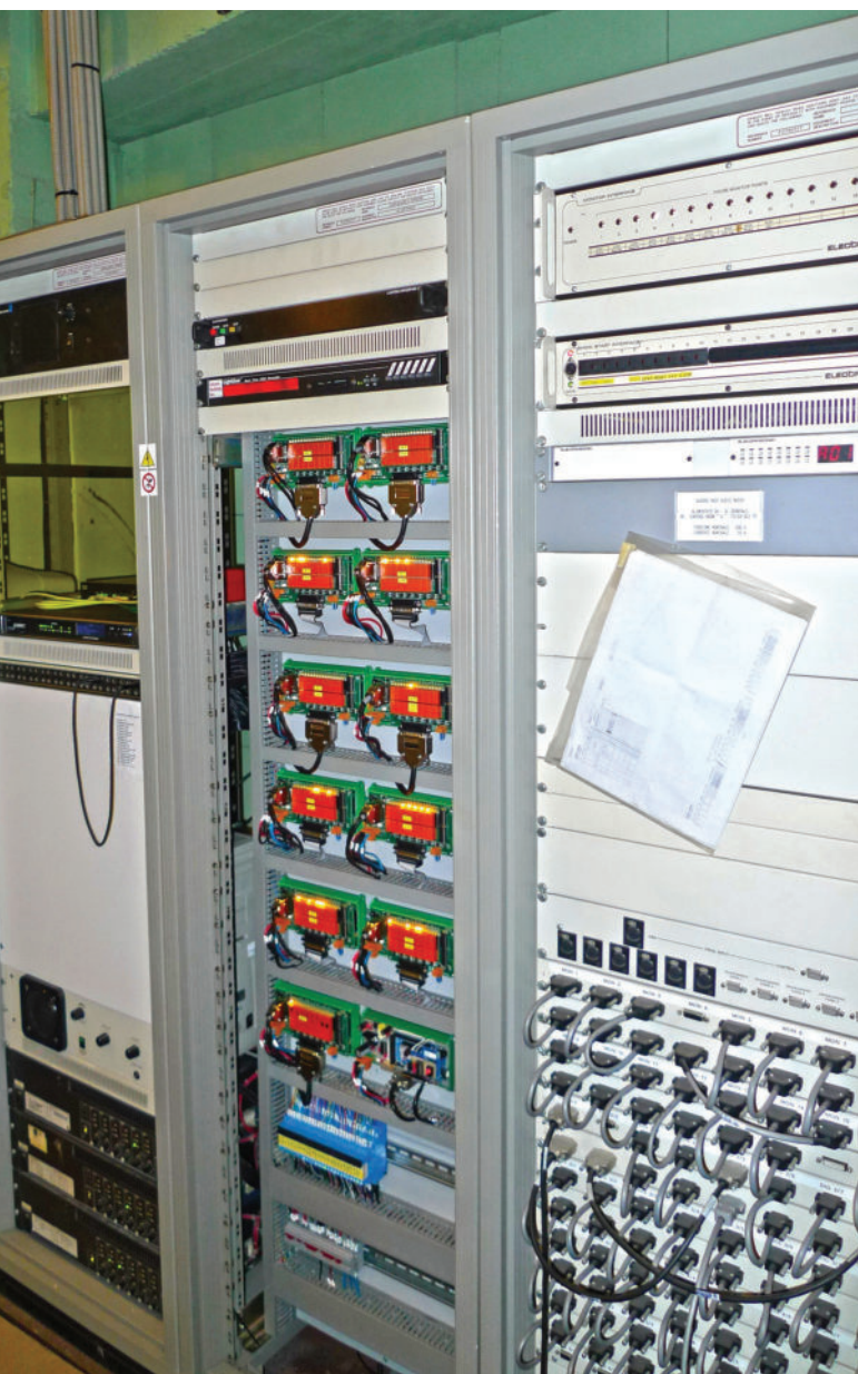
Uno dei 4 quadri di controllo di luci e scenografia de "I Corsari", in arancio con i LED gialli delle schede da me ideate per aggiornare il sistema originale (2010).
