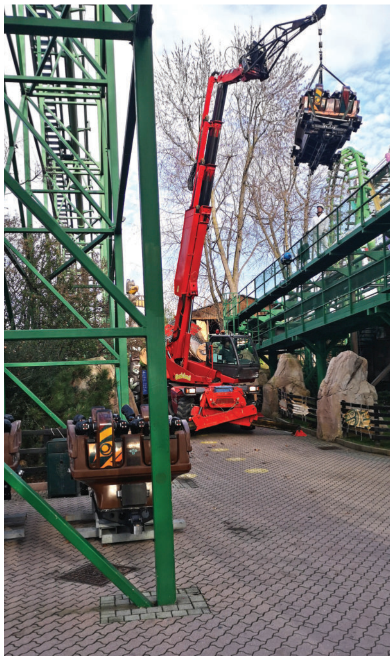
Parte del nuovo tracciato di "Magic Mountain" installato nel 2021. Rimozione dal percorso delle carrozze del treno "Magic Mountain" per la revisione invernale (2022).
